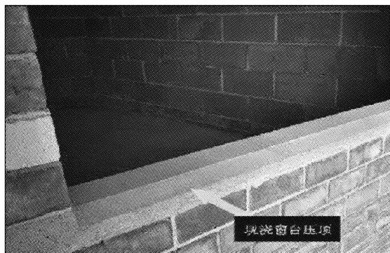
压顶内高外低形成一定坡度
