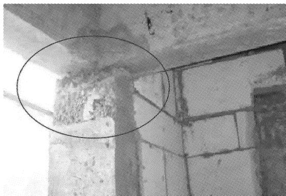
1. 外墙构造柱未一次性浇筑到顶, 二次浇筑后未振捣密实;
