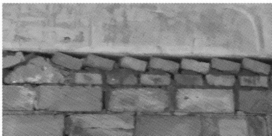
墙体顶部砌筑不符合要求,灰缝不密实
