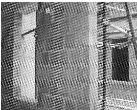
门窗框两侧未设置混凝土预制块或实心砖
