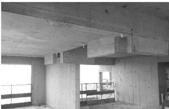
过梁与主体一次浇筑成型 (铝模板施工工艺)
