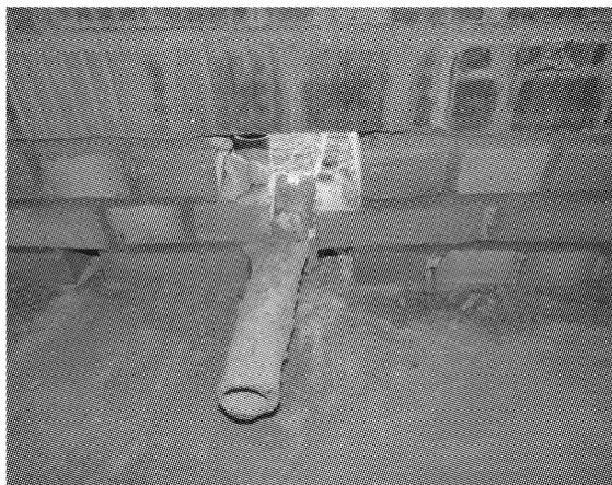
外墙脚手眼堵塞不严或封堵方法不正确导致外墙渗水
