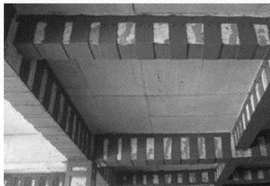
图1 碳纤维房屋结构加固技术
