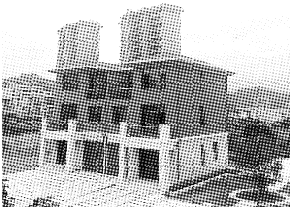
中建海峡发展有限公司全装配式结构样板楼
