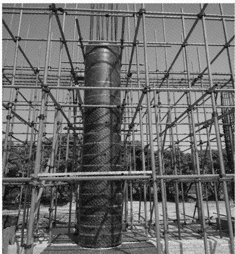
圆柱木模板安装及加固
