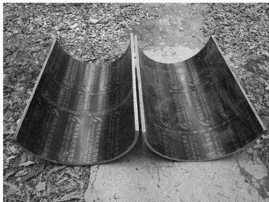
施工现场木质圆模板
