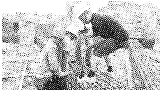
(直螺纹接头扭力距检查)
