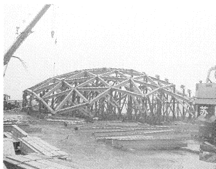
外球分片吊装现场
