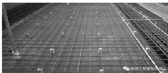
面筋保护层砂浆垫块应用示意图
