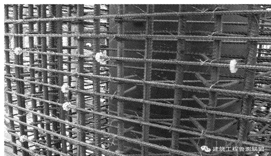
塑料垫块柱侧使用示意图
