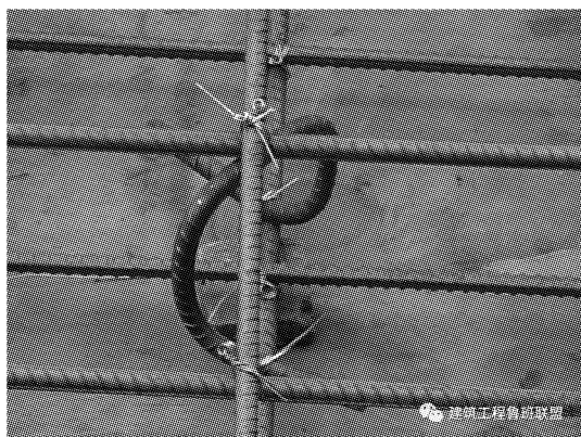
楼板钢筋间距定位做法应用实例
