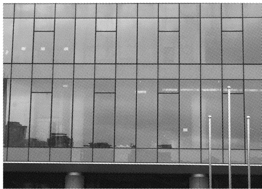
图3 玻璃幕墙层间透光处理效果
